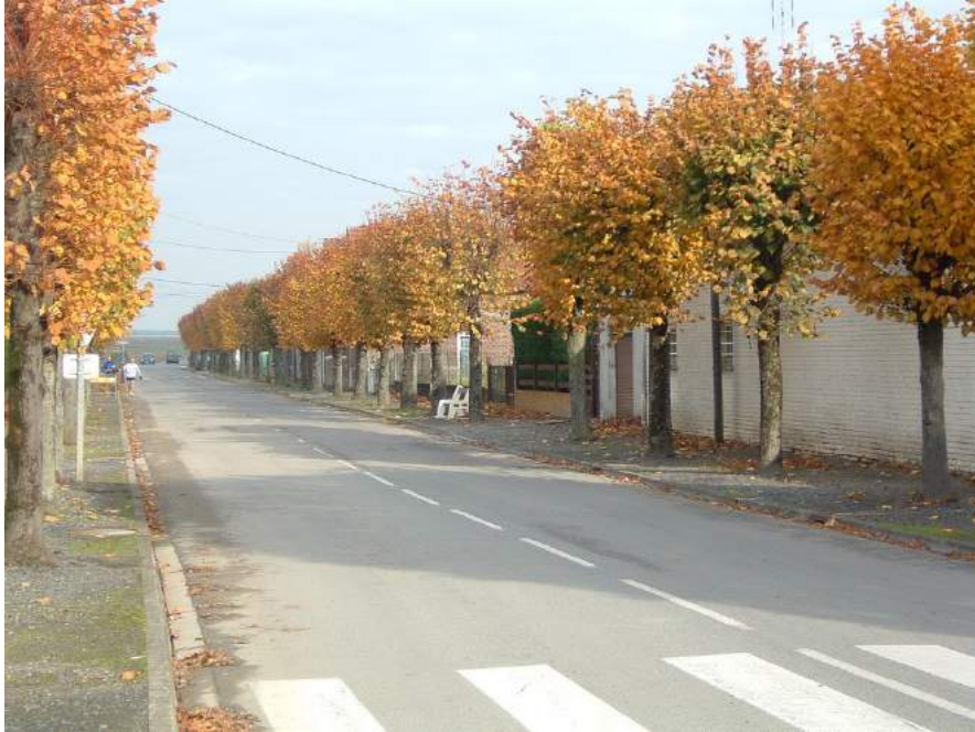
La rue Gambetta avant les travaux
