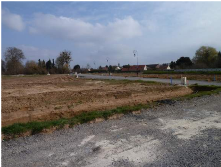
Viabilisation et réalisation de l'éclairage public..
