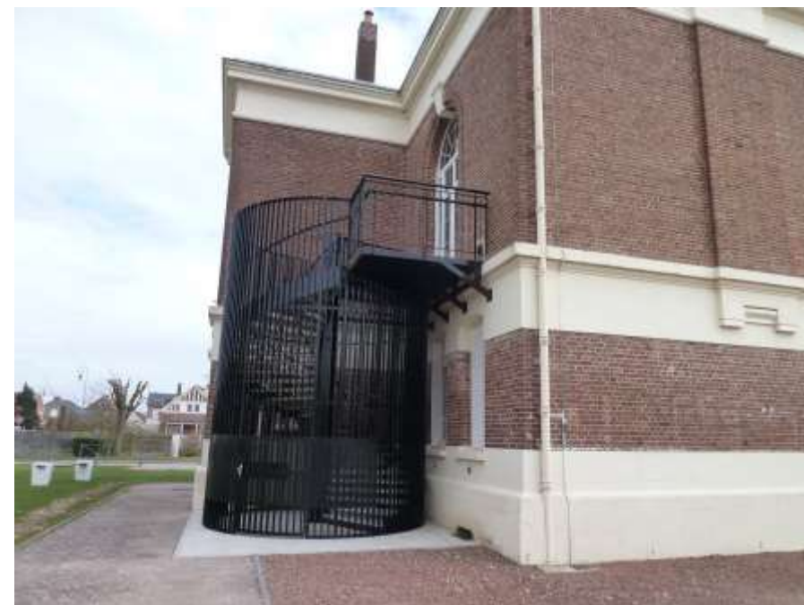
L'escalier de secours
